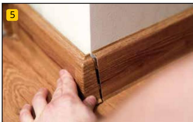
5 Montáž vonkajšieho rohu na ozdobjné lišty. Inštalácia vonkajšieho rohu na ozdobjné soklové lišty. Upevnenie vonkajších rohov na ozdobjné soklové lišty.
