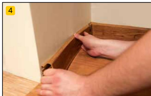
4 Montáž dekoratívnej časti listvy poprzec vsunięcie jej w narożnik. Montáž ozdobjnej časti sokla vložením do rohu. Upevnenie časti ozdobjnej soklovej lišty vložením do rohu.
