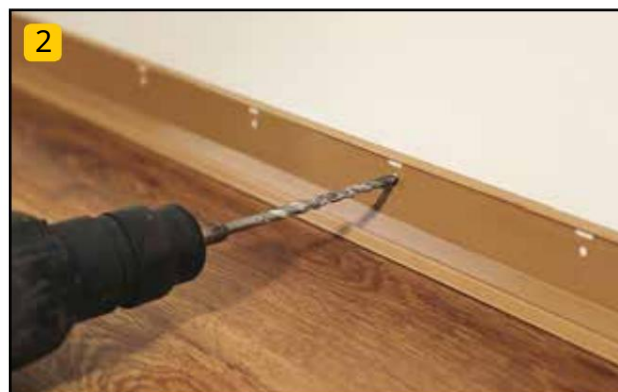
2 Montáž soklovej lišty pomocou rýchломontážnych kolíkov alebo lepidla. Montáž soklovej lišty pomocou rýchlopínacích hmoždienok alebo lepidla. Upevnenie soklovej lišty pomocou rýchlopínacích čapov alebo lepidla.
