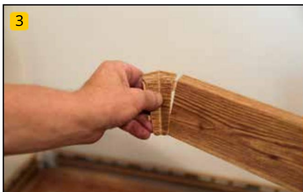
3 Inštalácia vnútorného rohu. Inštalácia vnútorného rohu. Upevnenie vnútorných rohov.
